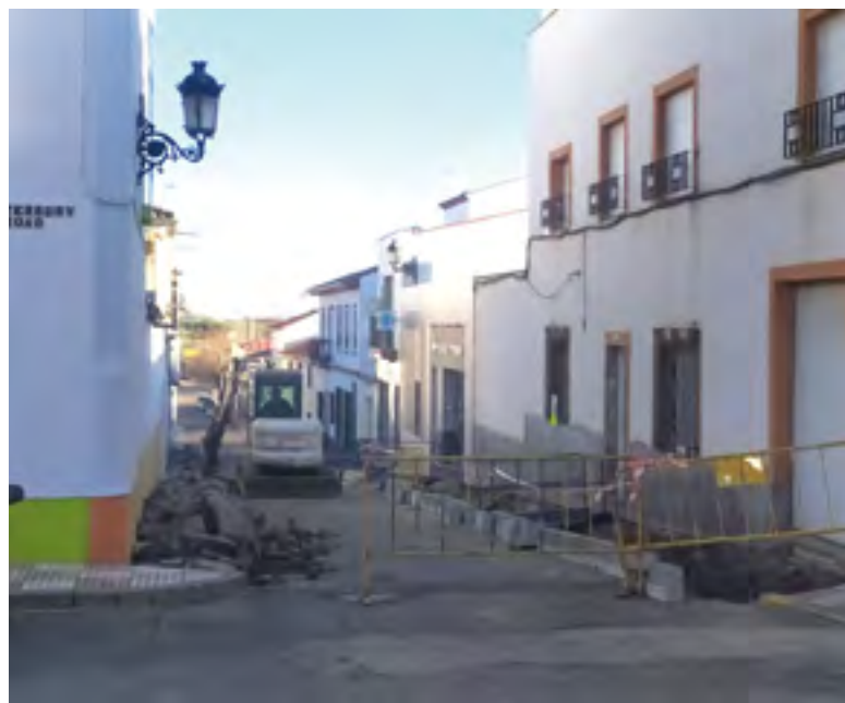
Trabajos que se están realizando en la calle Hernán Cortés
