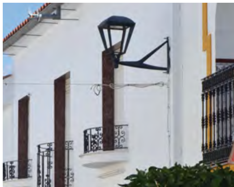
Luminarias que se van a instalar en Espiel
