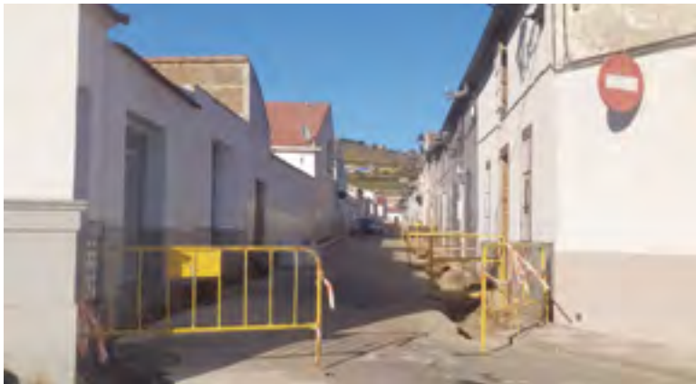
Actuación que se está realizando en la calle Colmenillas
