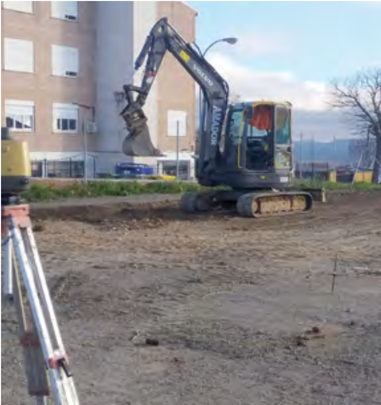
Trabajos de construcción del parque de calistenia
